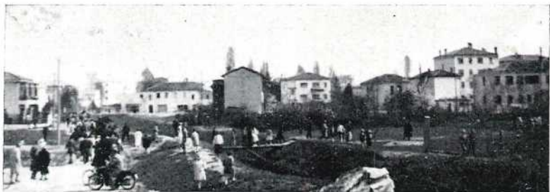
IL PRIMO PONTE (senza parapetti e senza luce).
